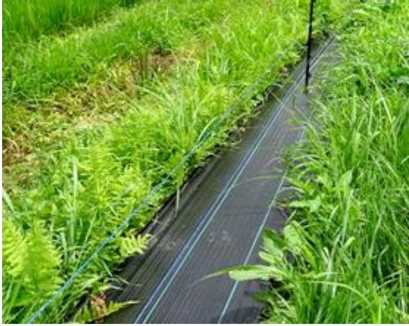
図2 防草シートBの敷設状況 (撮影日：平成27年7月29日)
