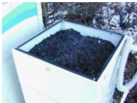
図6 脱臭槽内の腐葉土
