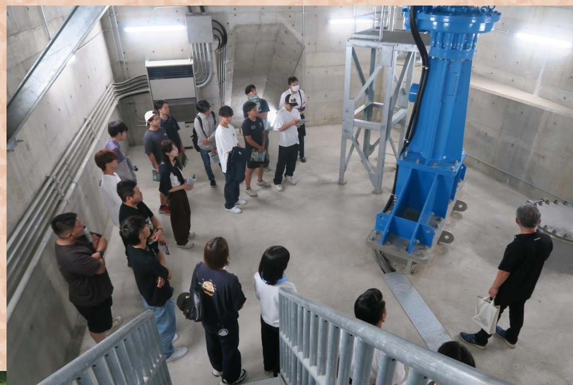
水位低下設備見学
