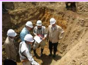
復旧委員会による土質確認
