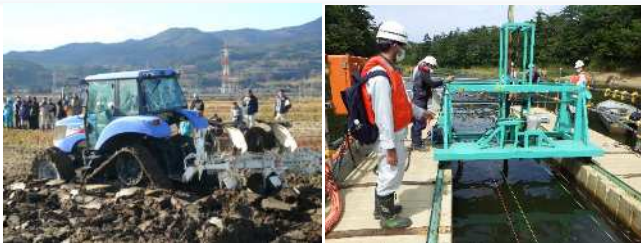
農地除染（トラクターによる反転耕）ため池の放射性物質対策
