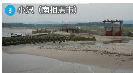
堤防の決壊・樋門の損壊
