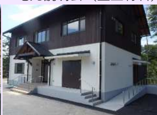
ダム管理棟の新設
