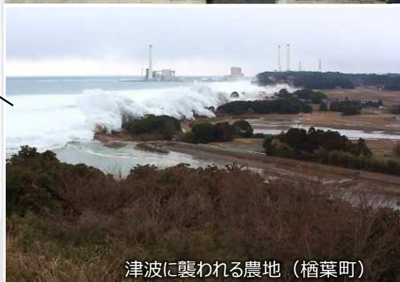
棚塩排水機場（浪江町）
