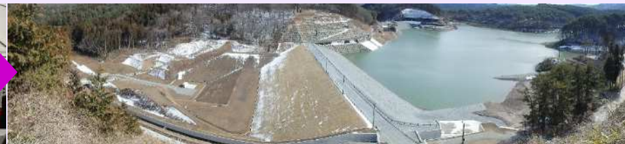
H29.3 湛水試験状況
