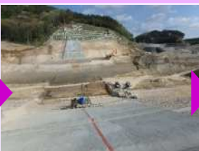
H27.5 本堤掘削完了
