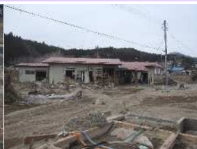
下流家屋の被害
