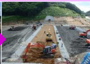
H28.6 本堤盛土状況
