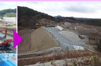
H28.12 本堤盛土完了
