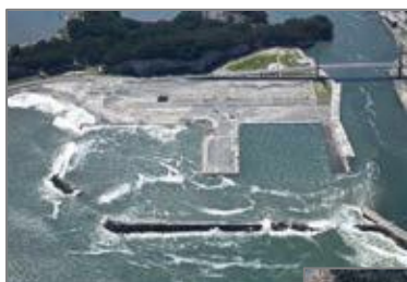
被災直後 （平成23年9月）
