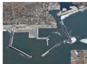
被災直後 （平成23年9月）
