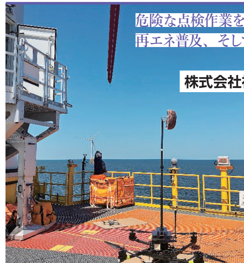
石狩湾新港洋上風力発電所で洋上風車のLPS点検に成功
