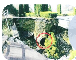
配水管 破損
