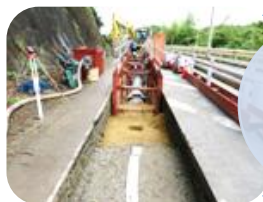
破損した 導水管を 複線化
