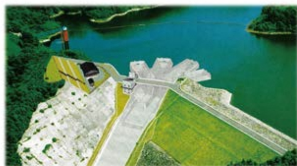
改築後：洪水調節機能あり
