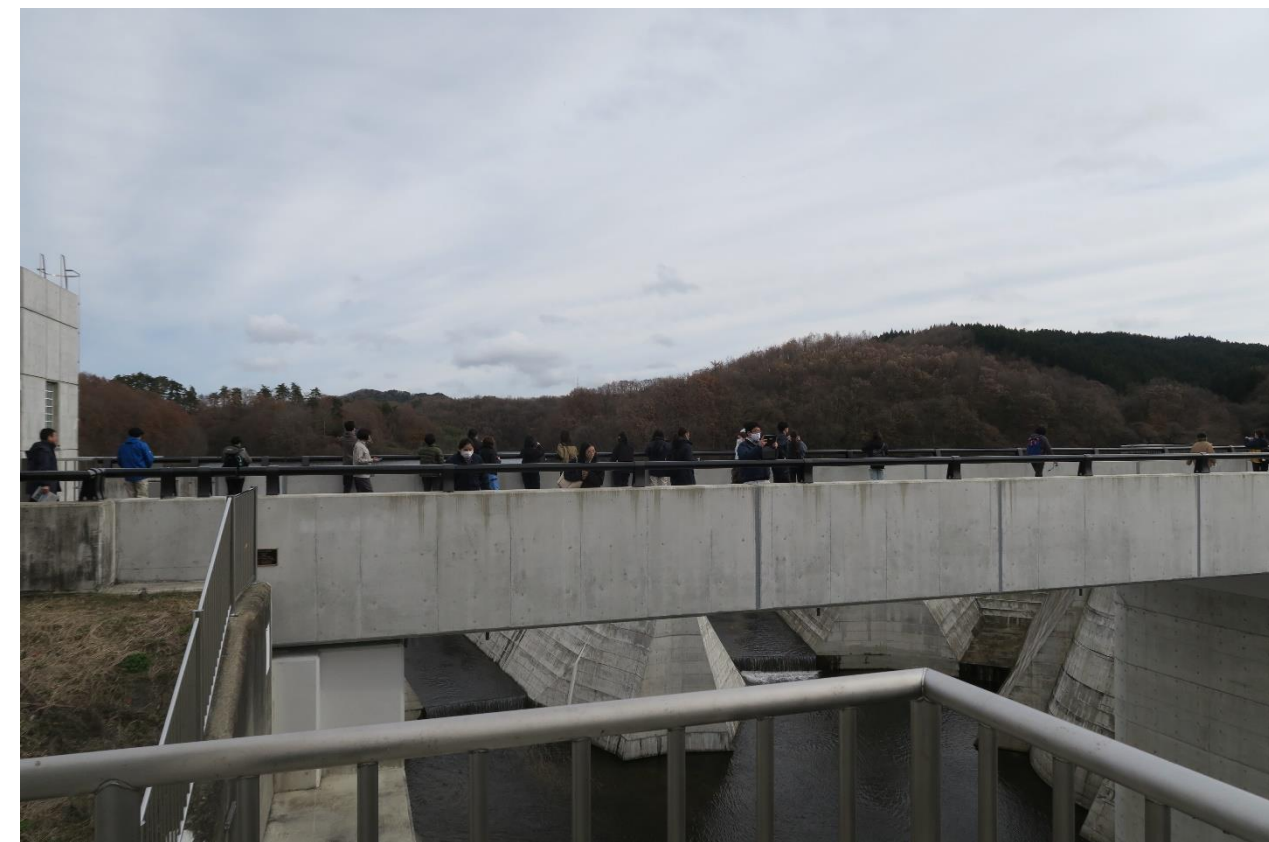
洪水吐部付近を現地見学
