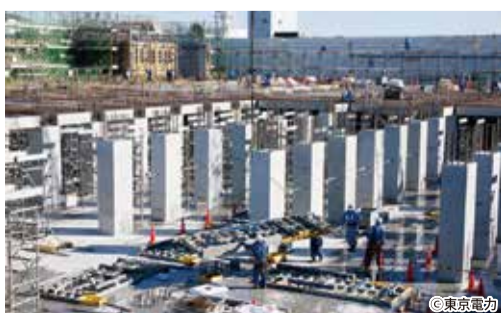
固体廃棄物貯蔵庫建設工事 地震、津波、水素爆発により発生したガレキを保管する施設を建設中です。
