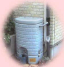
雨水貯留タンク
