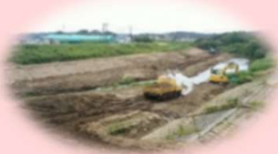
堤防強化・河道掘削
