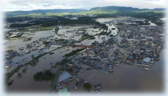
令和元年東日本台風（二級河川夏井川の決壊）
