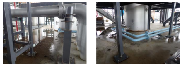
図1 RTFの試験用プラント
