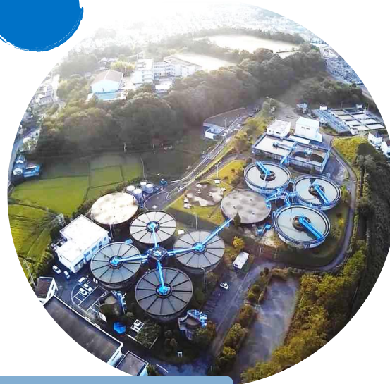
磐城工業用水道 泉浄水場
