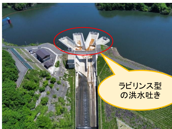
千五沢ダム全景
