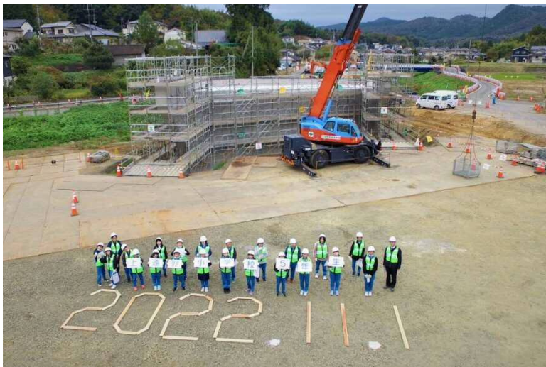
上遠野小学校現場見学会 ドローンによる記念撮影 2022. 11. 1
