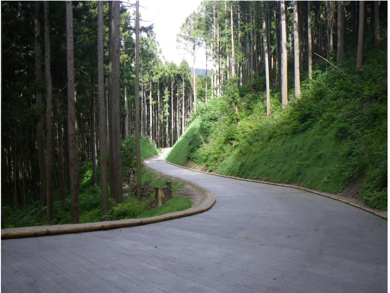
水ノ木羽山線林業専用道整備工事（田村市）
