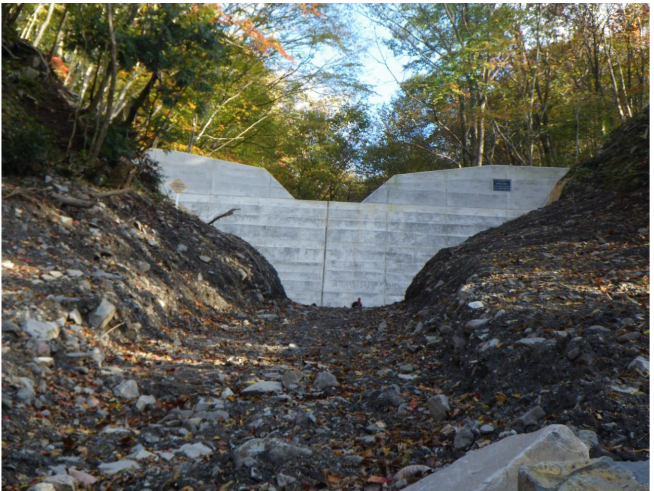
赤崩地区復旧治山工事（下郷町）
