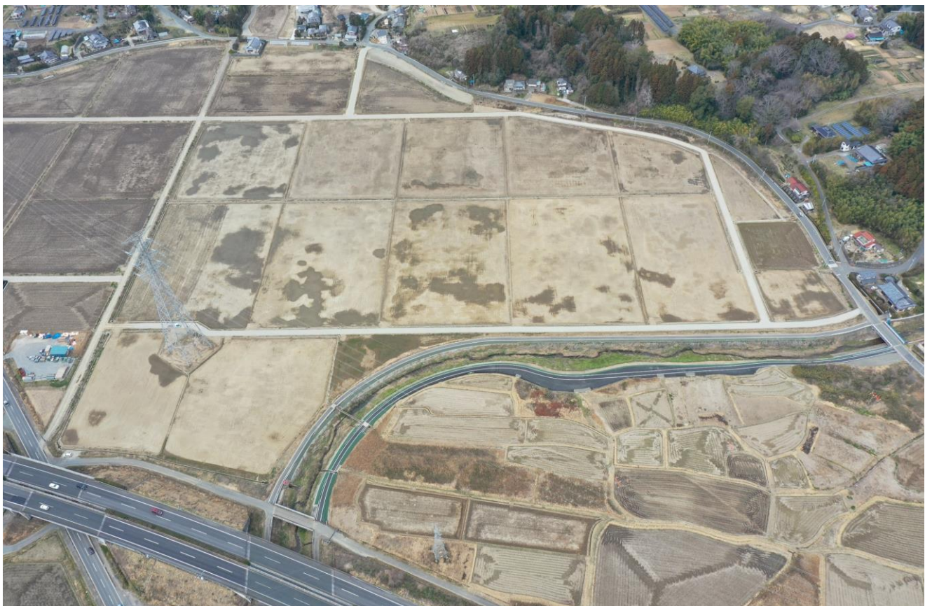
山田地区ほ場整備工事（いわき市）
