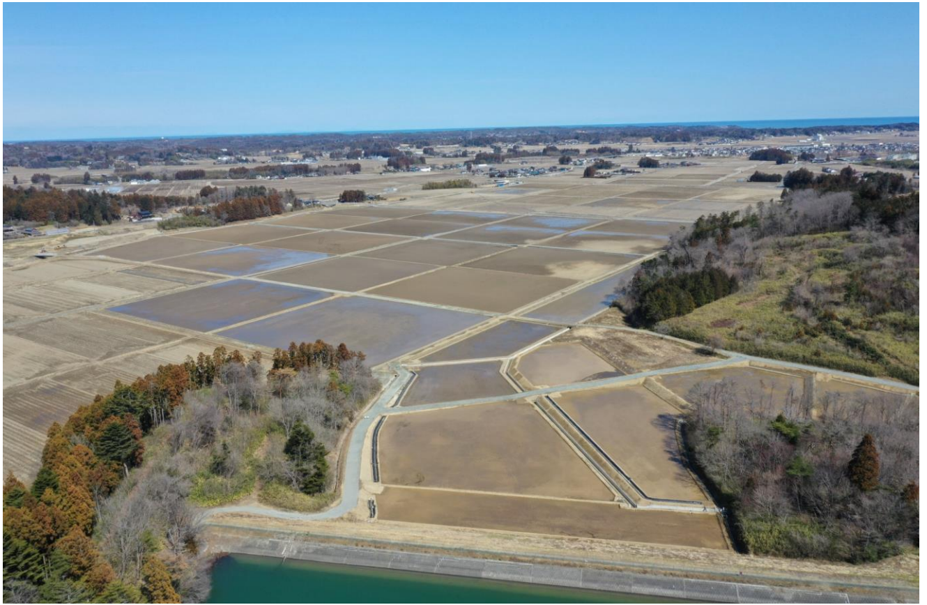
鹿島西部地区ほ場整備工事（南相馬市）
