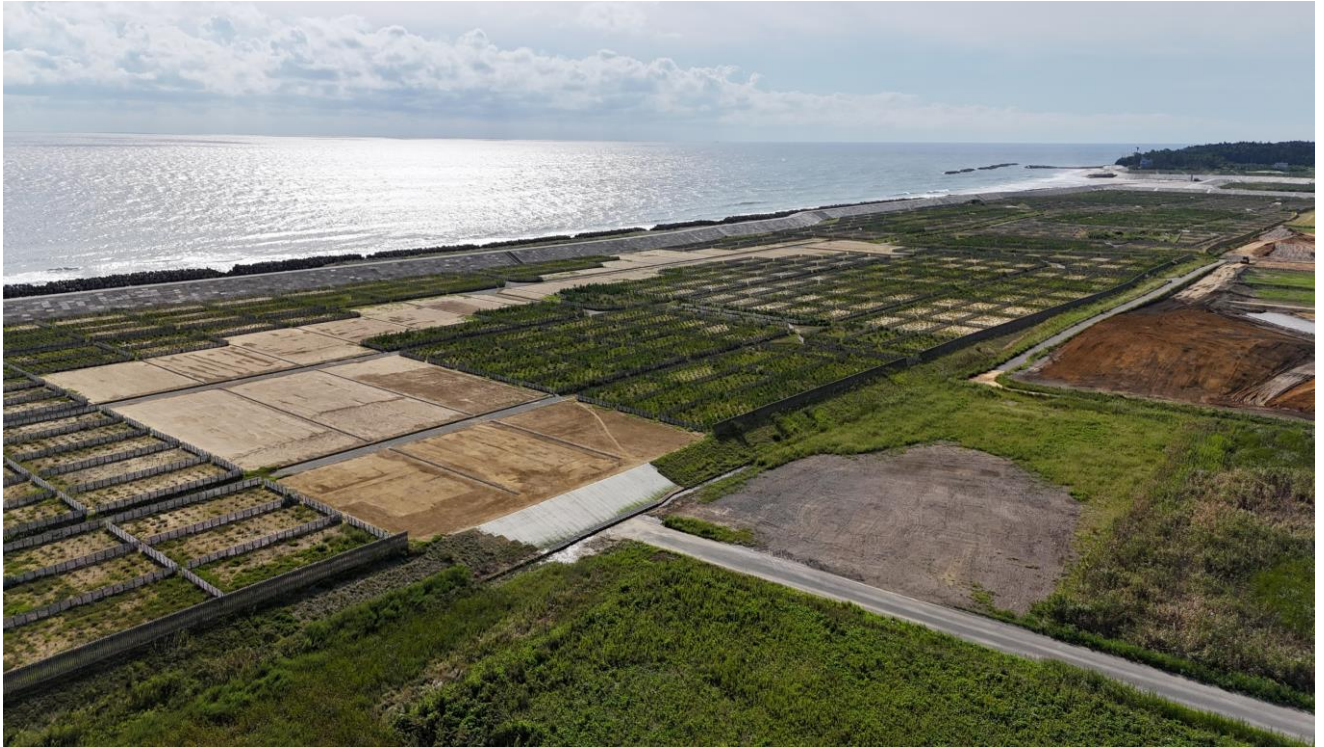
浪江地区防災林造成工事（浪江町）
