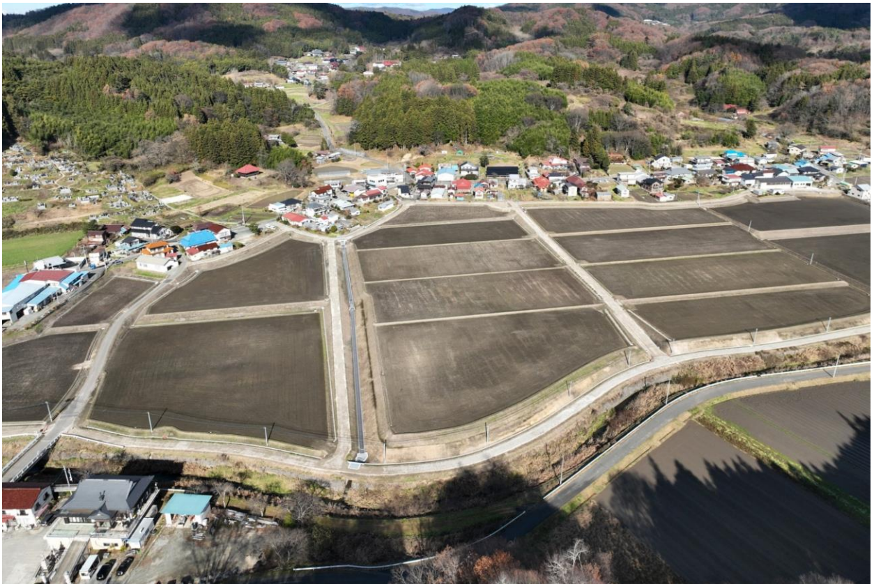
北移地区ほ場整備工事（田村市）
