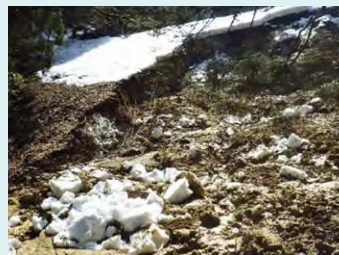
堤体の崩落
