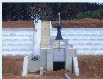
ゲートの点検
