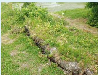
法面の崩落
