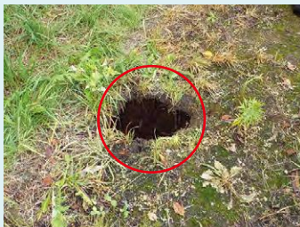
堤体の陥没
