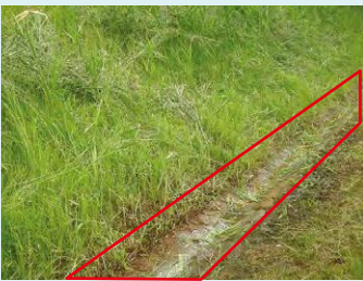
堤体法尻の漏水
