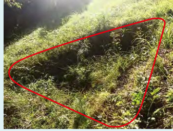
堤体の陥没
