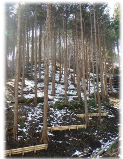
放射性物質拡散を抑制するための木柵
