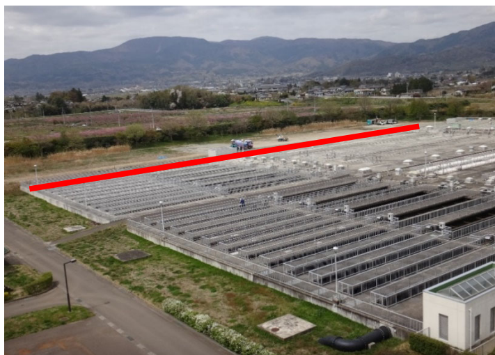
2 系列 6 池 電気・機械設備新設
