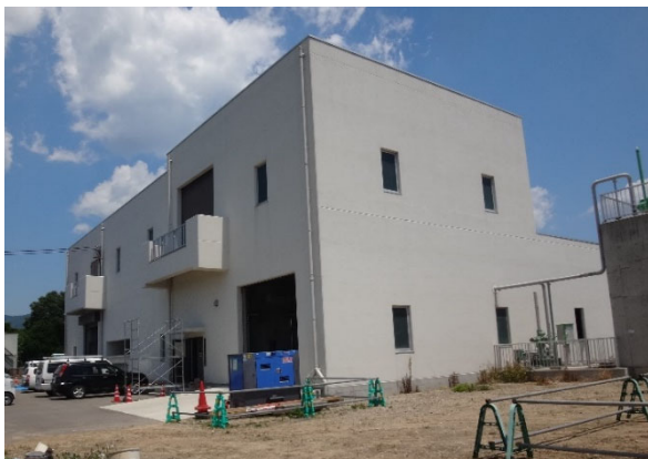
耐水化 (第 2SP 棟)
