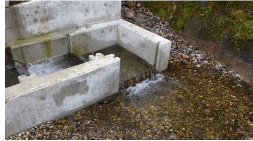
図3 魚道入口の状況
