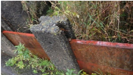
図8 魚道出口の角落とし
