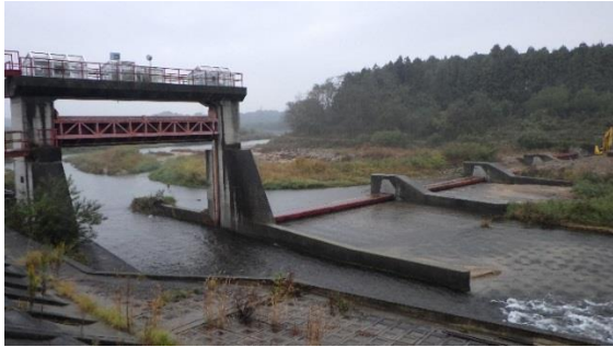
図6 請戸堰頭首工
