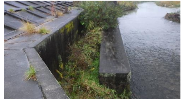
図9 魚道内部の状態
