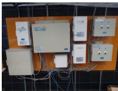
プロファイダーNext80(左)とLSスクリーン(右)の設置状況
