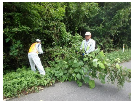
支障木撤去作業
