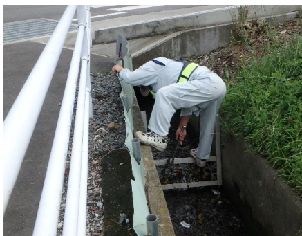
側溝清掃作業
