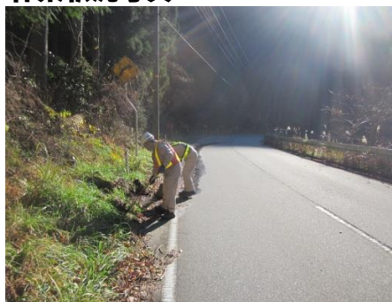
路肩清掃作業
