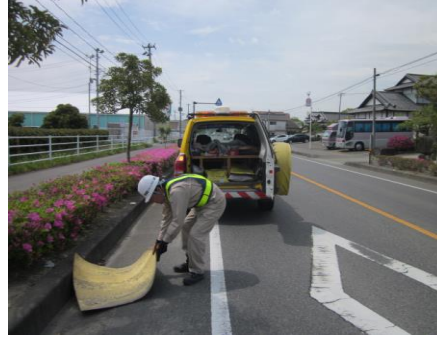
落下物撤去作業
