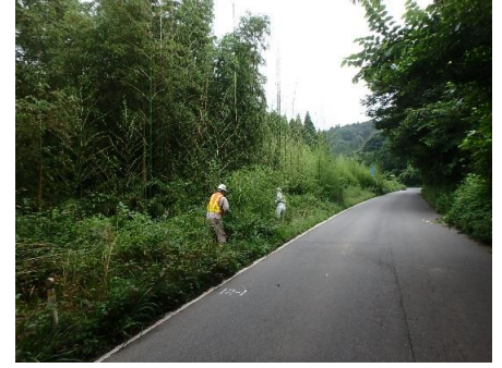
支障木撤去作業
