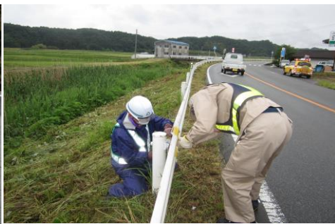
応急補修作業
