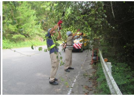
支障木撤去作業
