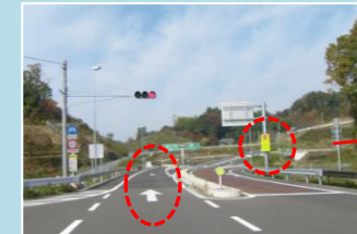
石川母畑ICで実施した逆走防止対策(路面標示と進入禁止看板の追加設置)
