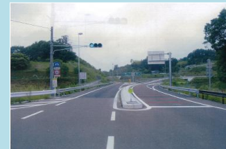
石川母畑ICで実施した逆走防止対策(路面標示と進入禁止看板の追加設置)
