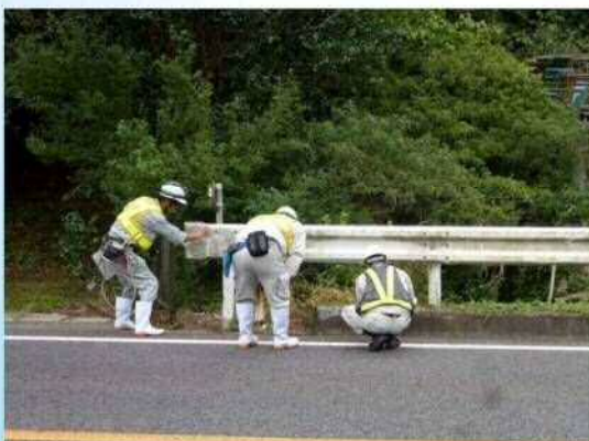
路面の損傷確認状況
