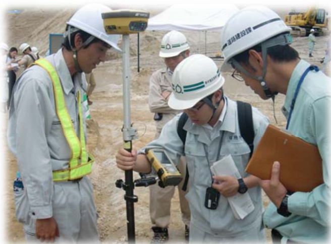
GNSSによる施工管理
