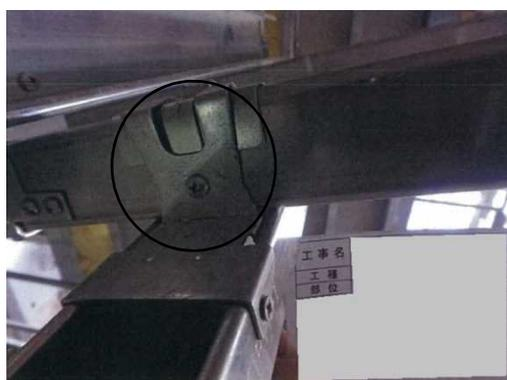
外れ防止補強 クリップをビス止め
