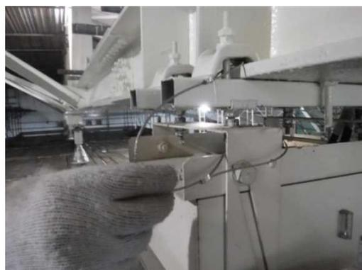
照明設備 ワイヤーによる落下防止措置
