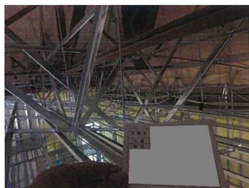
振れ止め防止補強 斜め部材設置
