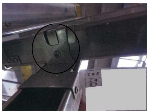
外れ防止補強 クリップをビス止め
