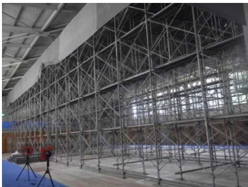
内部足場 撤去部全面に必要
