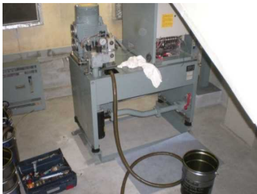
既存油圧ユニットオイル撤去
