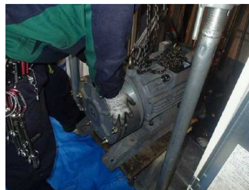
既存巻上機 撤去状況
