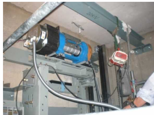
巻き上げ機新設
