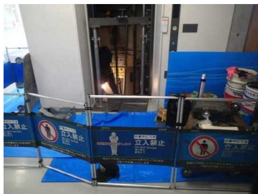
工事仮設状況
