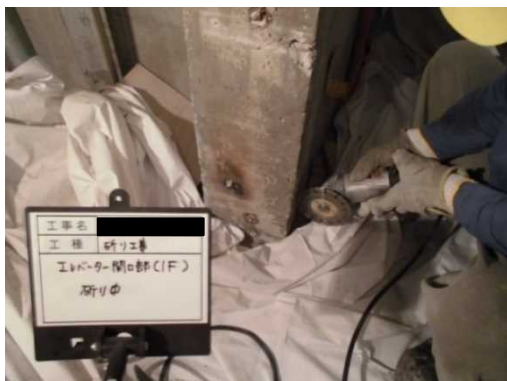
出入口間口の変更による躯体はつり
