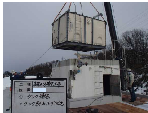
高架水槽撤去状況
