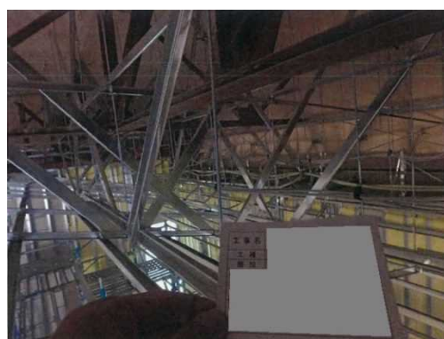
振れ止め防止補強 斜め部材設置
