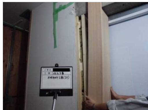
出入口間口部の内装工事
