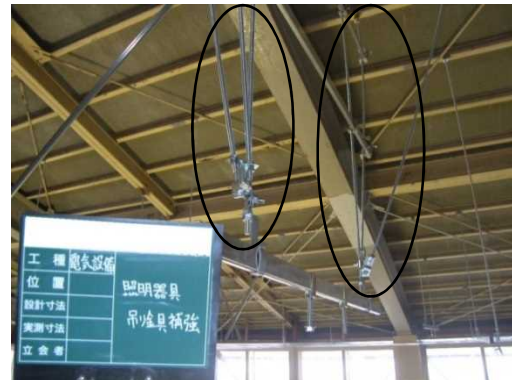
照明器具部 補強状況
