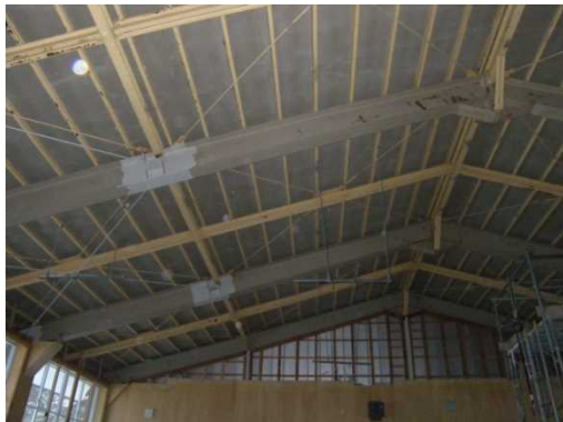
既存天井材撤去状況
