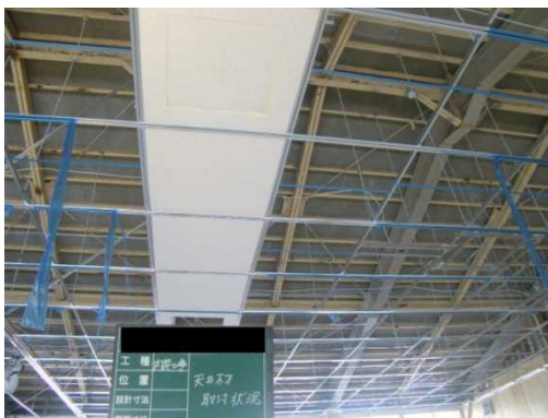
天井材（グラスウールボード）新設状況
