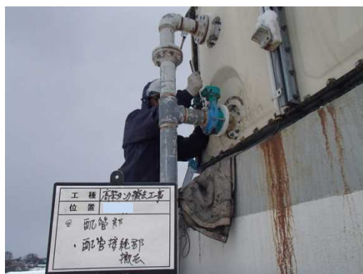
配管接続部 撤去状況
