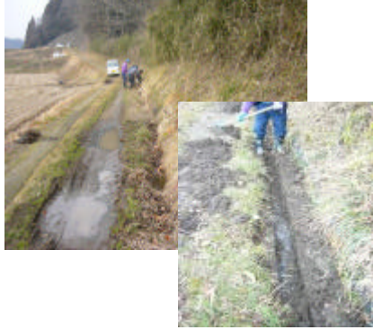
側溝清掃と道路砂引き作業実施 成田二区地区民と協力作業実施 2008年2月24日
