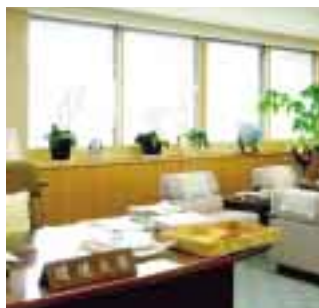
環境大臣室にも塩ビ樹脂サッシを採用
