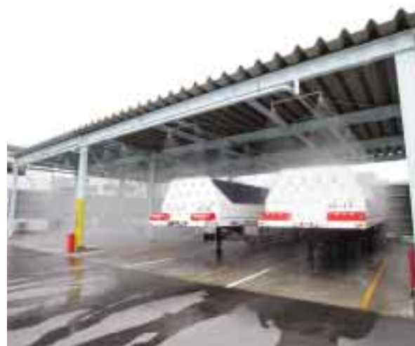
万が一の水素漏れ火災を想定した散水消火試験
