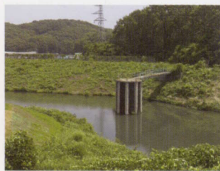
白河工場の水処理設備
