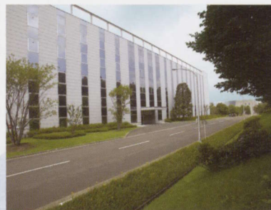
白河工場の製造棟
