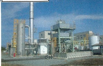
廃棄物焼却炉全景
