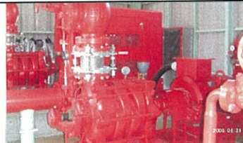
消火栓用水ポンプ（電気駆動とエンジン駆動）
