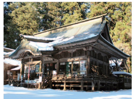
拝殿の様子。指定された本殿は、拝殿の奥にあります。
