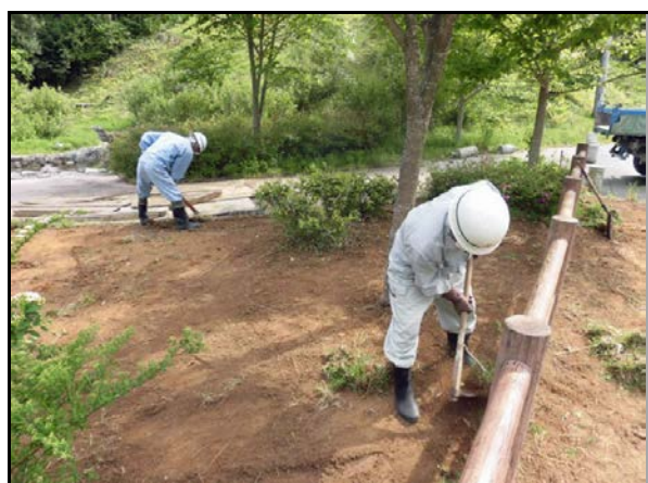
除染作業状況(公園施設)
