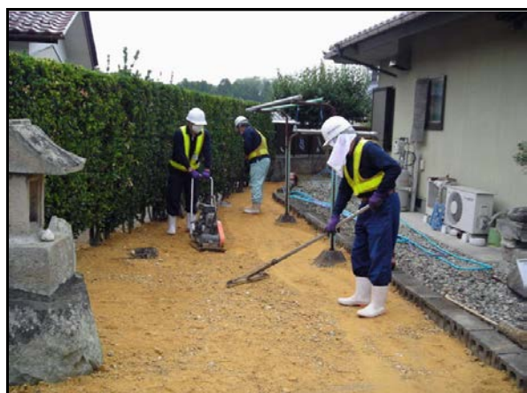
仁井田地区内住宅除染作業
