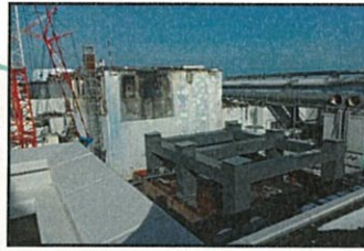
②第一節 鉄骨建方完了 (撮影日:平成25年1月14日)
