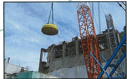
④格納容器上蓋の撤去 （撮影日：平成24年8月10日）
