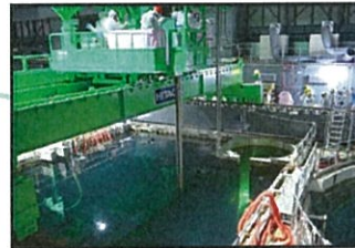
③燃料取り出し作業 (撮影日:平成25年11月18日)
