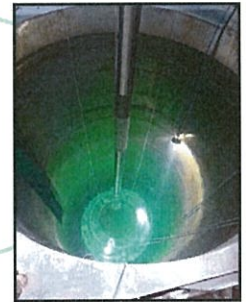
④キャスクへの装填 (撮影日:平成25年11月26日)
