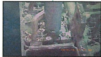
②燃料ラック上部ガレキ吸引作業 (撮影日:平成25年10月11日)
