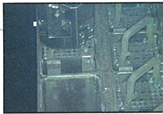
②燃料を積みラックから引き上げ (撮影日:平成25年11月20日)
