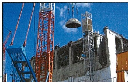
⑤圧力容器上蓋の撤去 （撮影日：平成24年9月13日）
