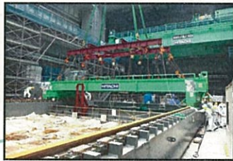
⑥燃料取扱機 部材据付け (撮影日:平成25年7月10日)
