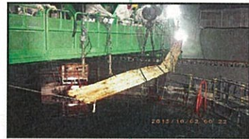
①大型ガレキの撤去 (撮影日:平成25年10月2日)
