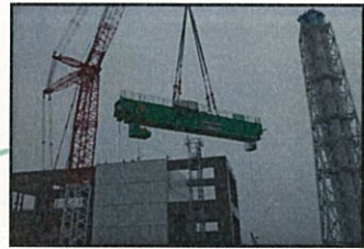
⑤天井クレーン部材吊り上げ (撮影日:平成25年6月7日)
