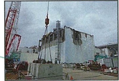
③撤去作業終了後 （撮影日：平成24年7月5日）
