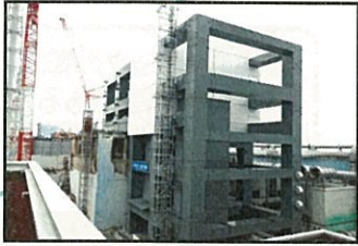
④鉄骨建方完了 (撮影日:平成25年5月29日)
