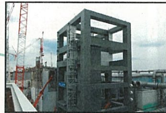
③原子炉建屋上部を除く鉄骨建方完了 (撮影日:平成25年4月10日)
