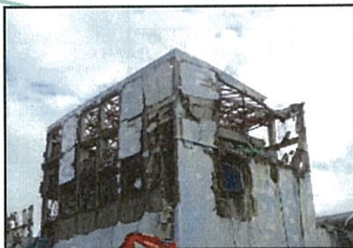
①ガレキ撤去前 （撮影日：平成23年9月22日）
