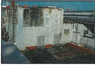
①鉄骨建方着工前 (撮影日:平成24年12月18日)
