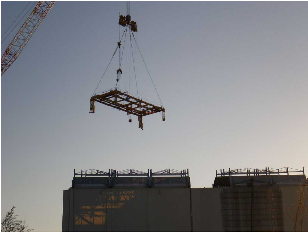
① クレーンで屋根パネル吊り上げ用の治具を屋根の上に移動しているところ。
