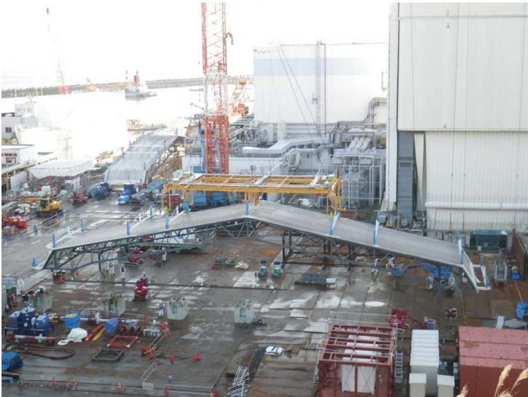
④ 仮置きヤードに屋根パネルを置くところ。線量測定を実施し、放射性物質による高い表面汚染がないことを確認。
