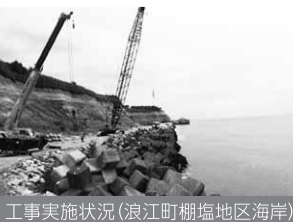
工事実施状況(浪江町棚塩地区海岸)
