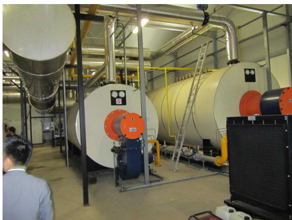
コージェネレーションシステム（電気と熱を同時に発生させる熱電併給システム）
