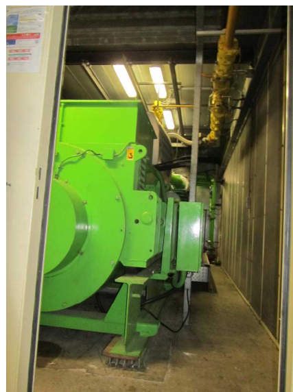
コージェネレーションシステム（電気と熱を同時に発生させる熱電併給システム）
