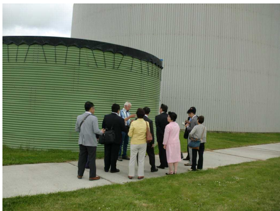
温室の外にある「雨水タンク」
