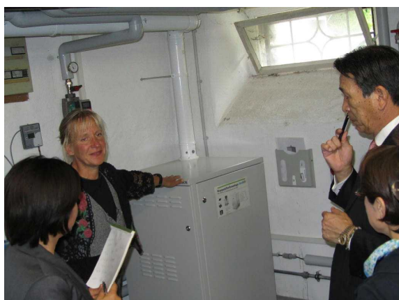
会社の地下にある発電機（コージェネレーション装置）
