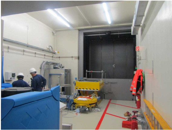
施設内作業状況
