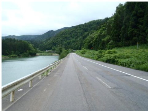
施工箇所（国道252号 水沼地内）
