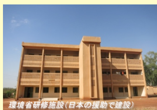
環境省研修施設(日本の援助で建設)
