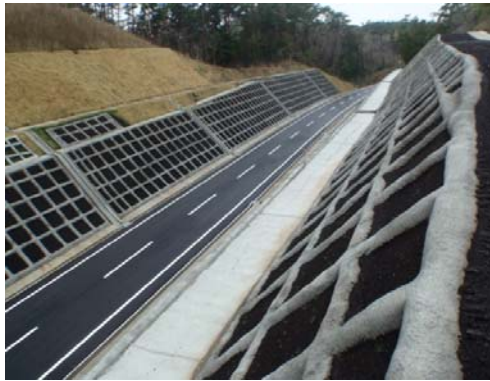
(四倉側 舗装工事・法面保護工事)
