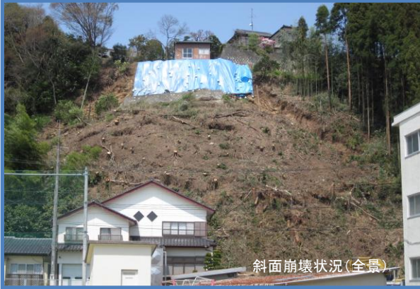
工事着手前(斜面崩落状況)
