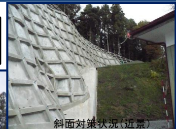
斜面对策状況(近景)
