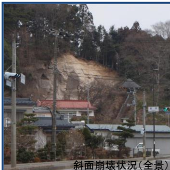
工事着手前 (斜面崩落状況)
