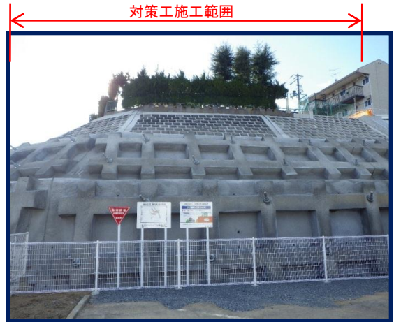
工事完成(平成25年12月)
