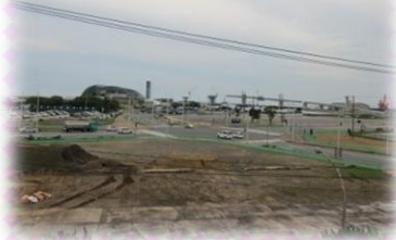
小名浜港の復旧状況
