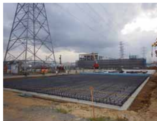
<凍結プラント基礎の構築状況>
