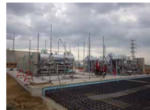
<凍結プラント 冷凍機設置状況>
