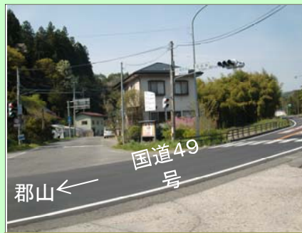
施工前(終点側)
