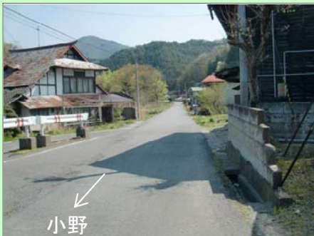
施工前(起点側)
